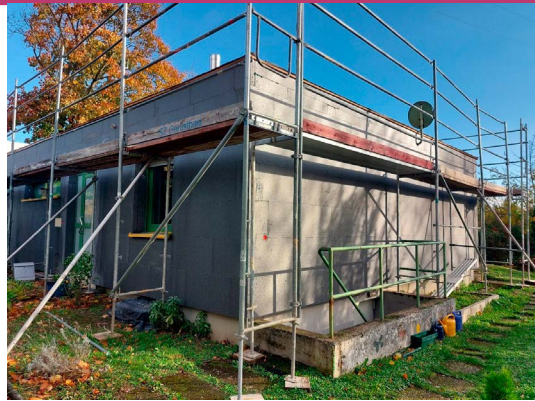
Energetische Sanierung der Hausmeisterwohnung Grundschule „Kleine Kalmit“ © VG Landau-Land
