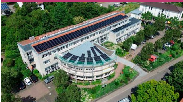
Die neue PV-Anlage auf dem Dach des Ratssaals der Verbandsgemeindeverwaltung Edenkoben © Engelstrom
